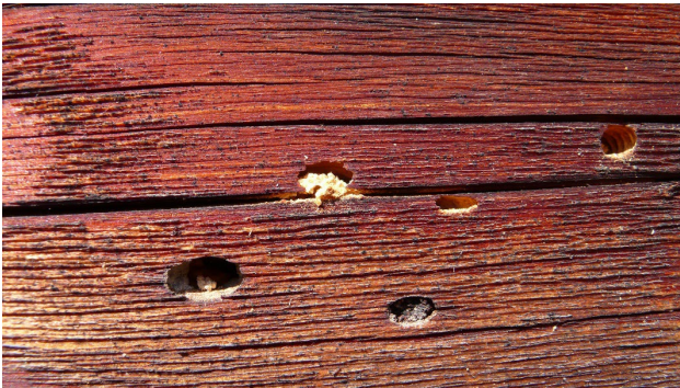
Typisch an den Ausflugsöchern ist die ovale Form. Im Bild kann man Kotpellets einer Larve erkennen, was auf einen aktiven Befall hindeutet. Bild: Stadt Zürich, UGZ
