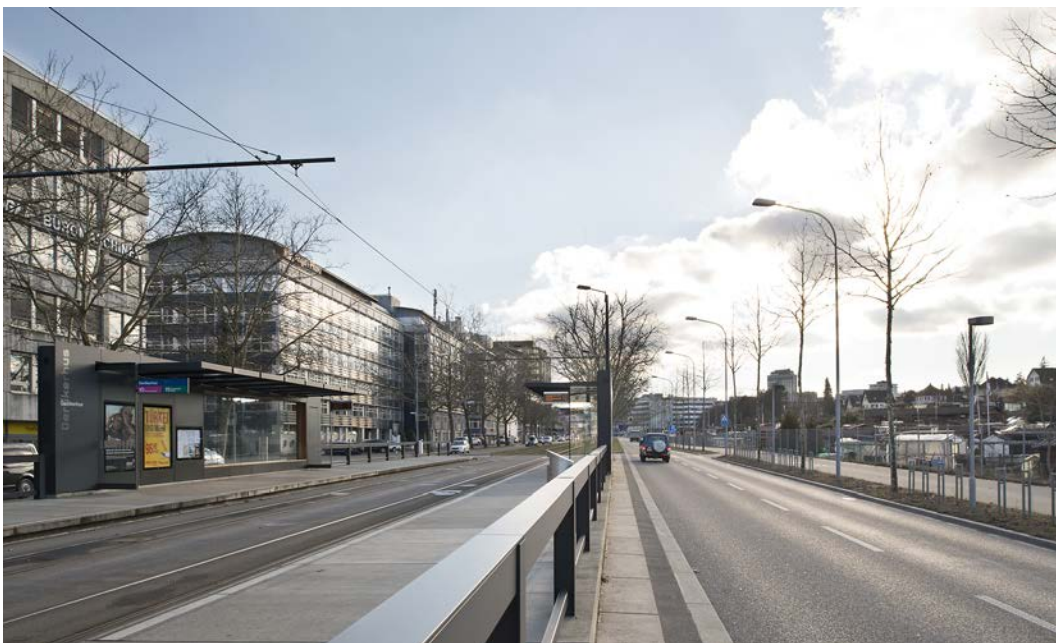
Trasse Glattalbahn und Strassenraum Thurgauerstrasse (Haltestelle Oerlikerhus)
