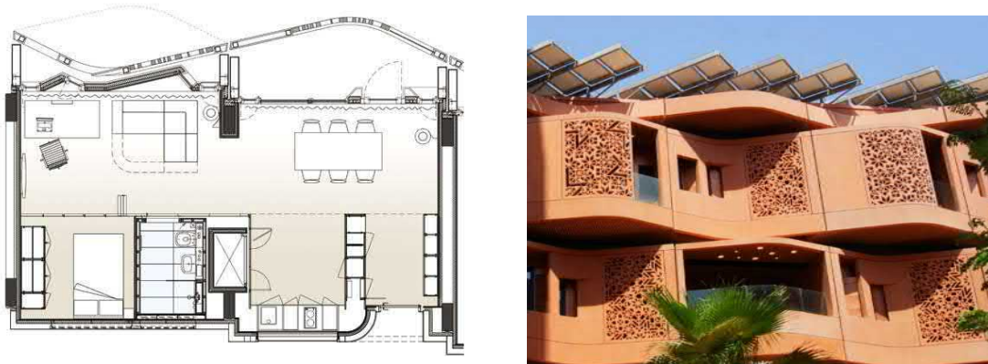
Abbildung 1: Fassadeintegrierte Lüftungsöffnungen im Wohngebäude des Masdar Institutes, Vereinigte Arabische Emirate [5]
