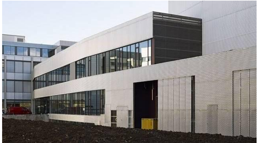
Abbildung 20: Hauptstandort OIZ Albis: Der Neubau erhält das MINERGIE-ECO-Label als erstes Verwaltungsgebäude, das die Stadt Zürich erstellt hat.
