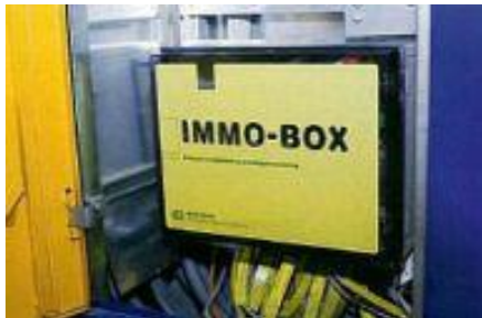
Abbildung 27: IMMO-Box zur automatisierten Erfassung der Energie- und Medienverbräuche.
