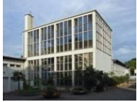
Bauprojekt / Gebäudetechnik Genehmigte Finanzierung: Fr. 34'000*
