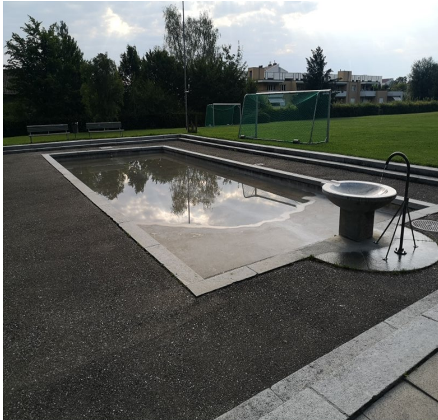
Heutiger Zustand der Anlage (Ansicht 1)
