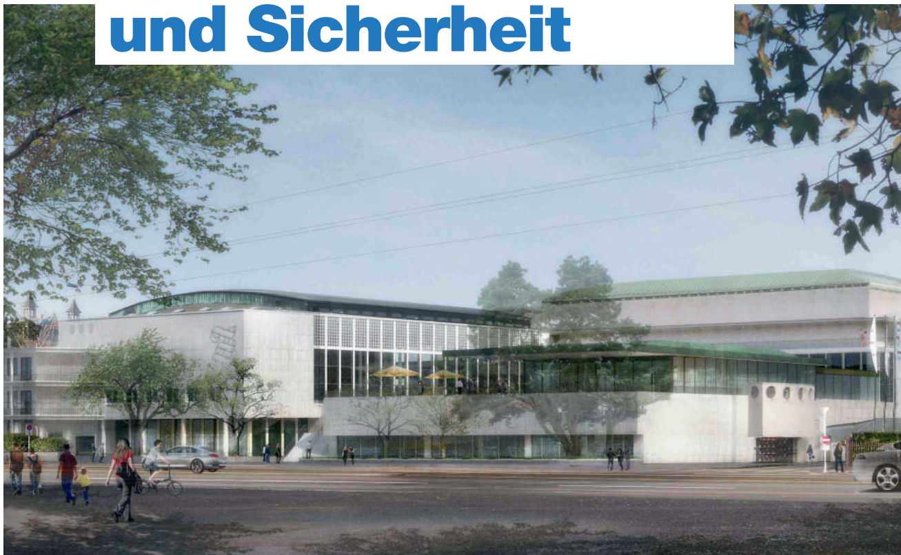
Kongresshaus in Fusswegdistanz zum Sechseläutenplatz.
