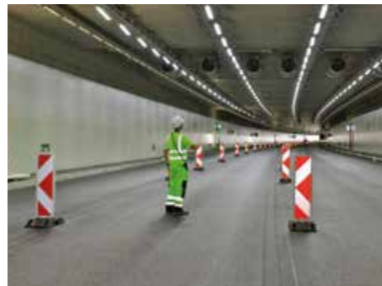
Innenansicht der Überdeckung Katzenssee, 2019 Quelle: Bundesamt für Strassen ASTRA
