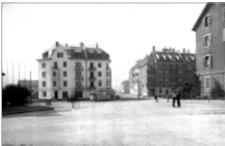
Blick von der Nordstrasse auf die Tramendstation Nordbrücke am Röschibachplatz. Foto: Tiefbauamt Zürich 1908 (Baugeschichtliches Archiv der Stadt Zürich).
