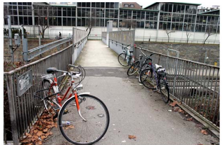
Defizit ❷: Fehlende Abstellanlage Seite Kalkbreite
