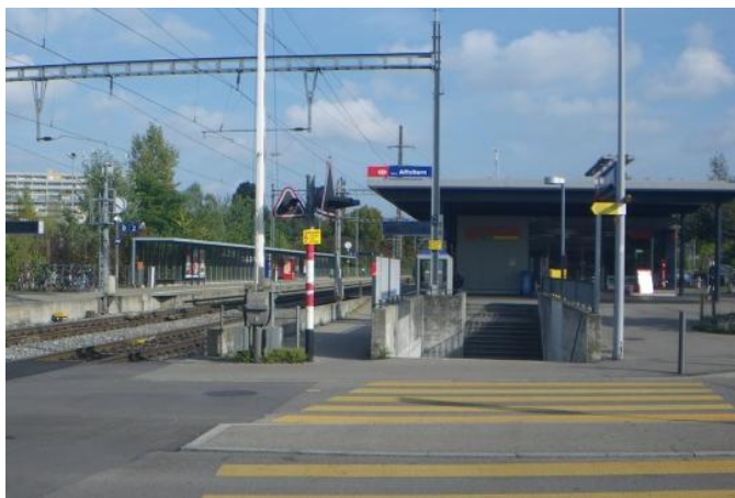
Defizit ⑤: Zugang Südperron von Westen her nicht klar erkennbar.
